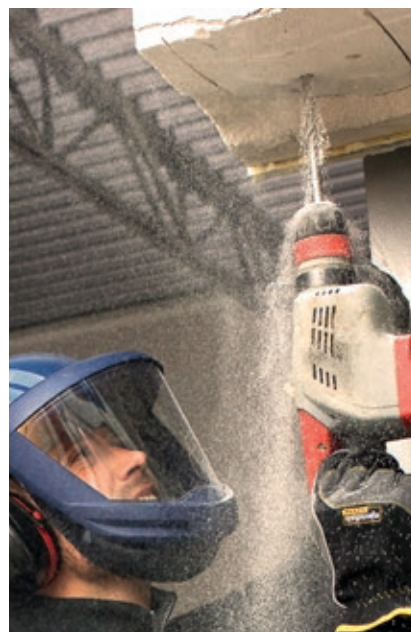
SR 580-hjelm med visir eller SR 570-ansiktsskjerm med eller uten støthette avhengig av arbeidssituasjonen.
